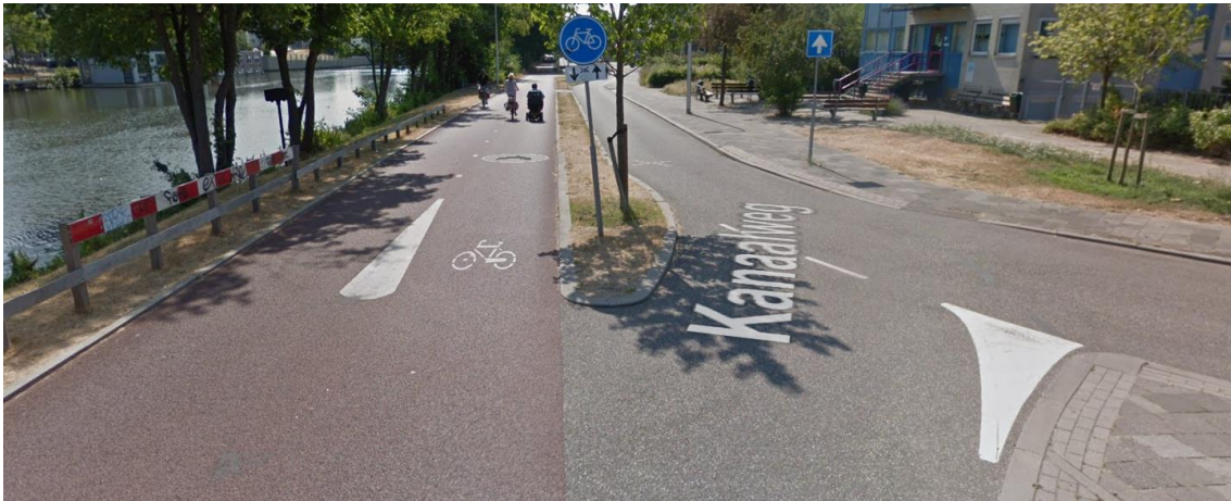
Fiets te gast splitst zonder paaltje in fietspad en rijbaan voor auto's Kanaalweg ten zuiden van Muntbrug
